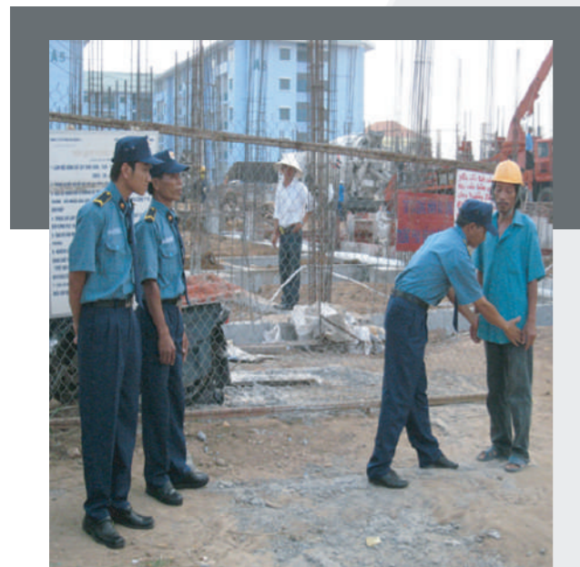
Nhà máy - công trường xây dựng
